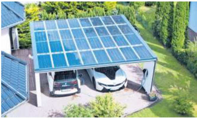
Das Carportdach mit Solarglas Modulen lässt sich zur nachhaltigen Stromgewinnung nutzen. Foto: DJD/www.solarcarporte.de
