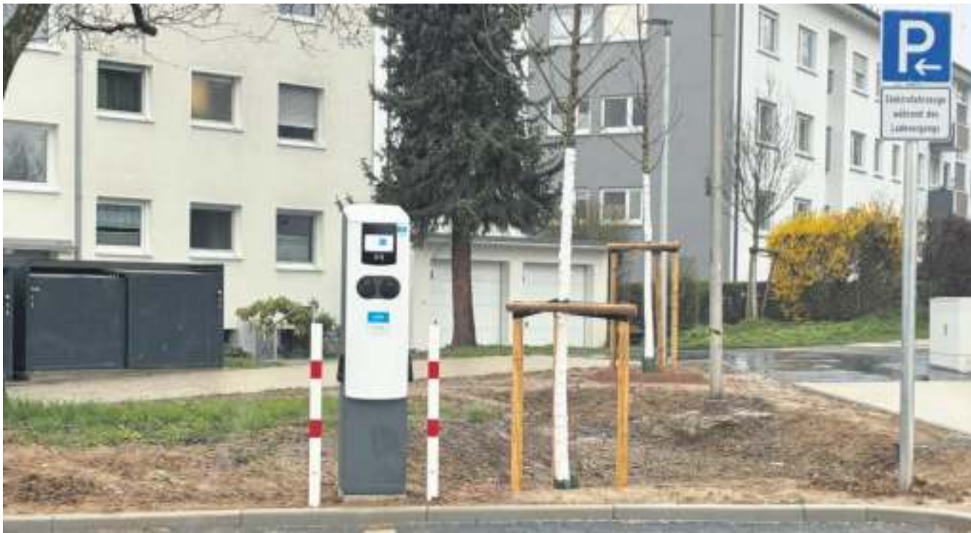
In der Hornbergstraße 36 in Kornwestheim hat die SWLB Mobilität GmbH im April eine neue Ladesäule mit zwei Ladepunkten installiert.
