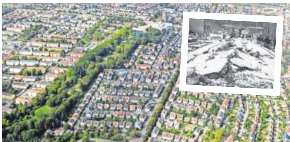
Der Stadtgarten wurde Mitte der 30er Jahre angelegt. Auch der Zusammenstoß 1961 von zwei Kesselwagen auf dem Rangierbahnhof (kleines Bild) ist Thema im neuen Heft.
